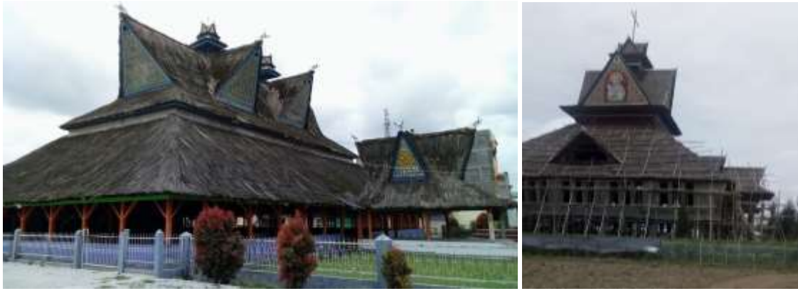
Gambar 2, 3. Jambur Taras di Kota Berastagi. Sebagai fasilitas kota, jambur diperbesar kapasitasnya dengan konstruksi baru walaupun bahan bangunannya masih menggunakan kayu (kiri). Gereja baru dengan konstruksi beton bertulang mengimitasi bentuk lama (kanan). Pencanggihan bentuk atap yang atraktif memberi kesan yang ikonik. Sumber: Dokumentasi pribadi, 2021.
